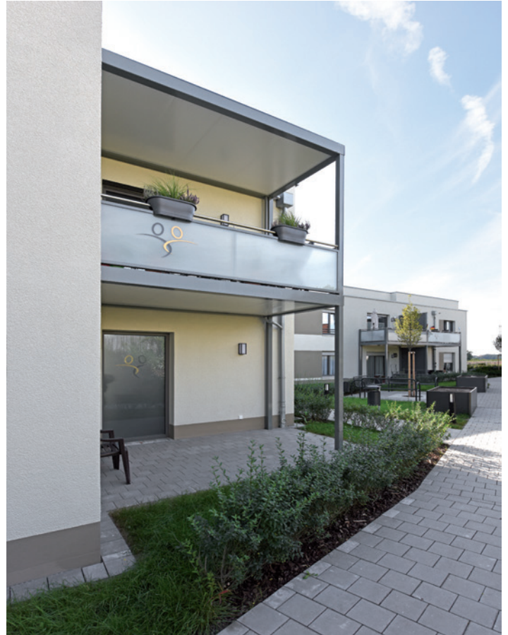
Oberer Balkon mit Flachdach in Form einer Balkonplattform.
