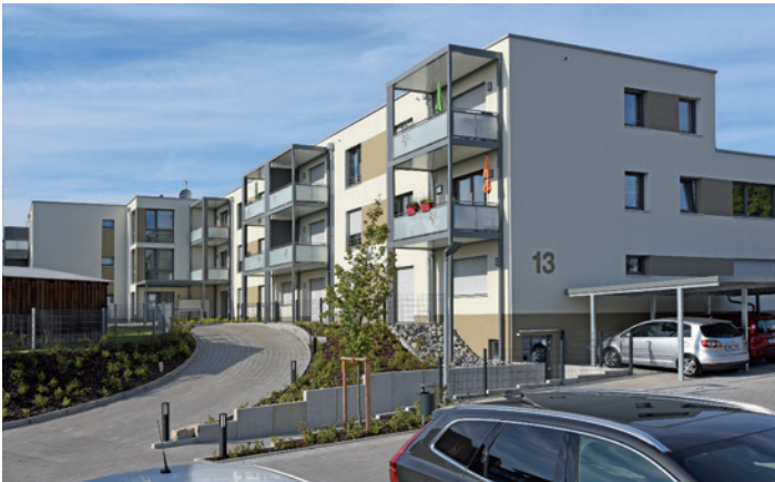
Spittelmeister-Systembalkone aus Aluminium mit einer Balkonverkleidung aus mattweißem Glas plus Logo-Siebdruck. Die Handläufe sind aus Edelstahl.
